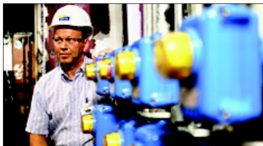
NYE RØYR: Verkstaden har levert røyr til den nye kjemikaltankaren som for tida ligg i hamn i Florø for ein siste finpuss. Desse røyra skal føre vatn og skum ned i motoren ved ein eventuell brann.
